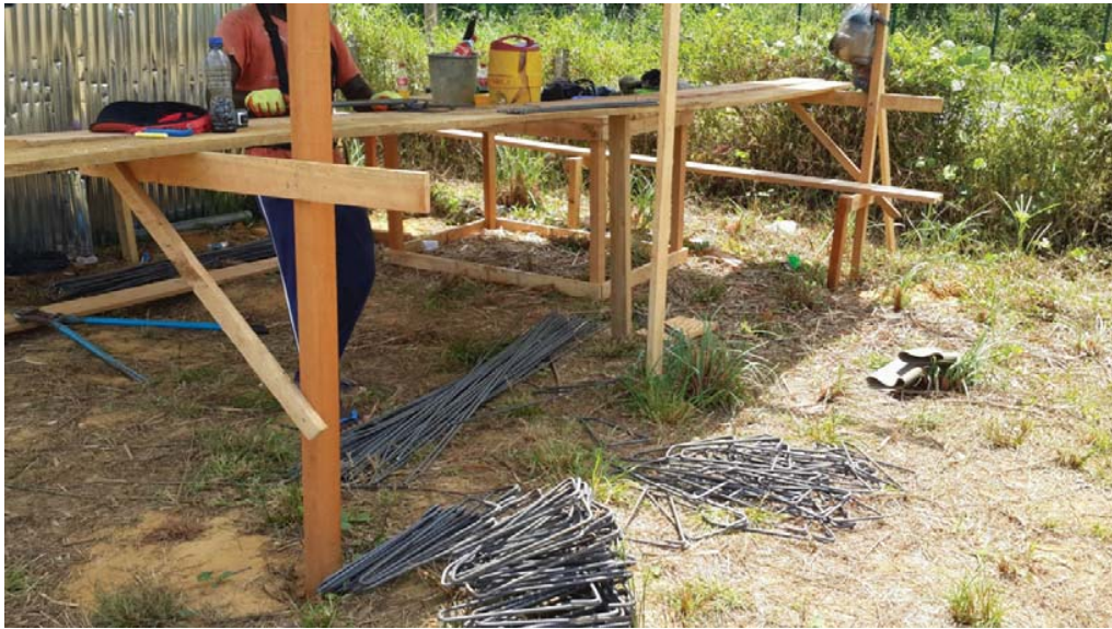
2014-09-17 –betonijzer vlechten tbv fundering
