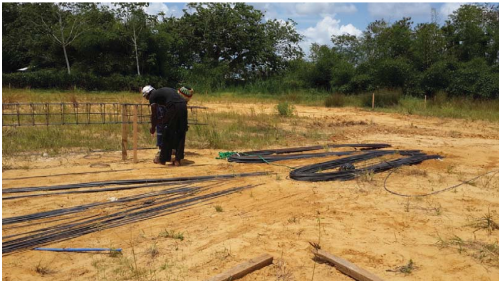
2014-09-17 –betonijzer vlechten tbv fundering
