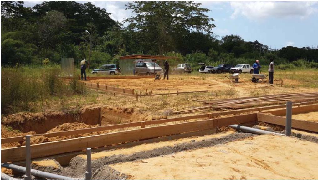
2014-09-17 –werkvloer funderingssleuven
