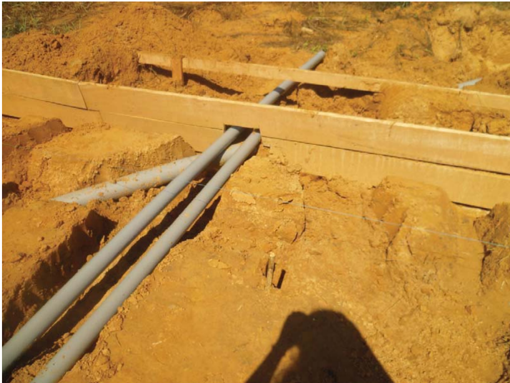
2014-09-12 – uitzetten van pvc binnen afvoeren
