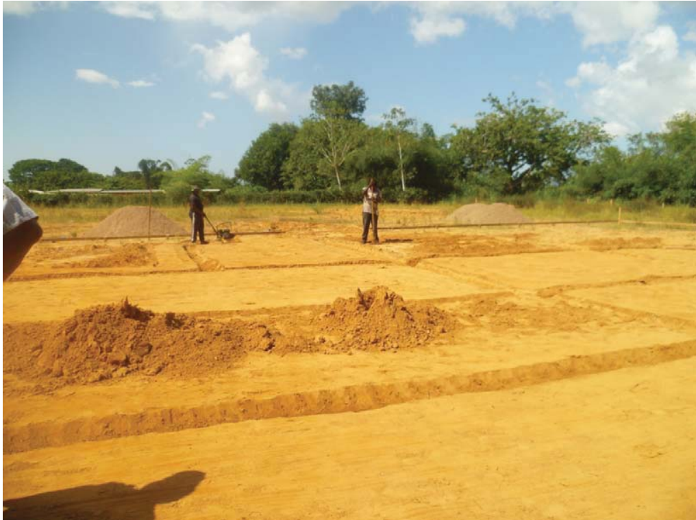
2014-09-08 - aanvullen en stampen opgevulde zand en graven funderingssleuven
