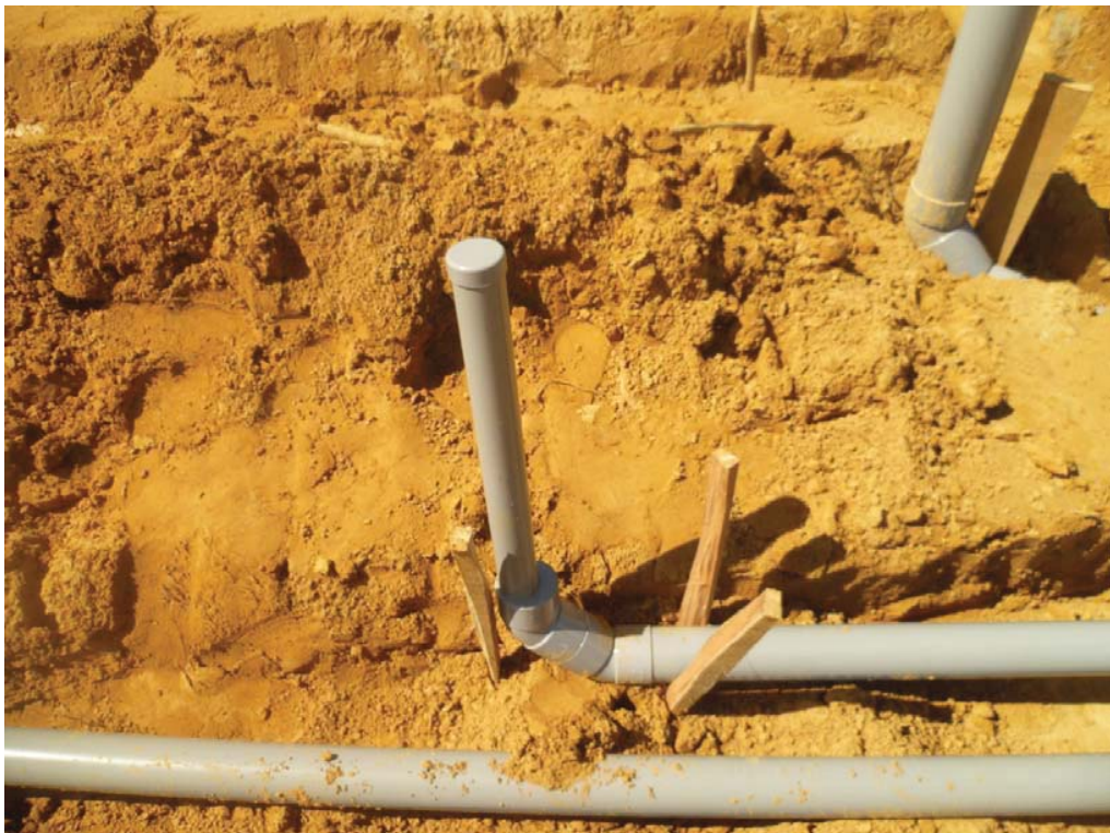
2014-09-12 – uitzetten van pvc binnen afvoeren
