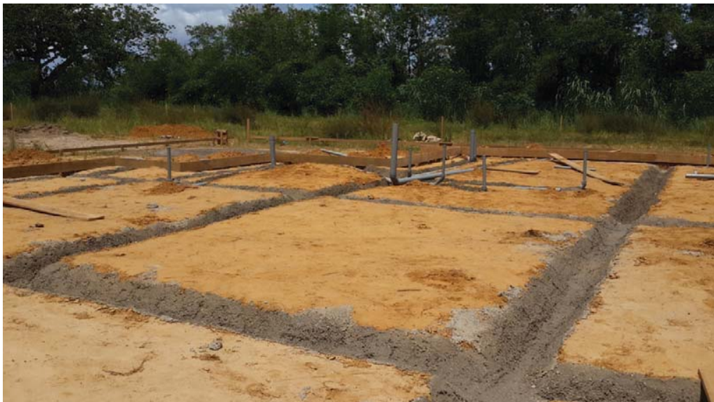
2014-09-17 – werkvloer funderingssleuven
